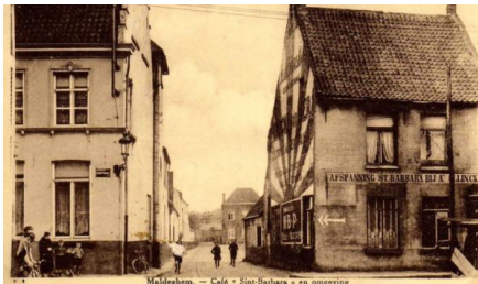
De afspanning Sint-Barbara, op de hoek van de huidige Schouwborgplaats en Marktstraat. Links de woning Verkindere, in het midden het “Tramstraatje”.
